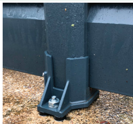
Fixation d'une platine de palissade sur béton.
