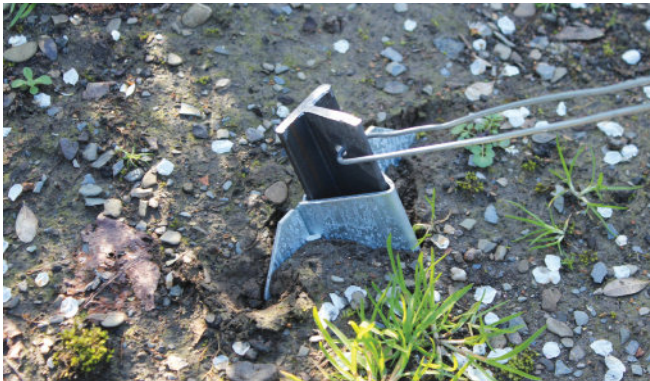
Ancrage renforcé grâce à la croix.
