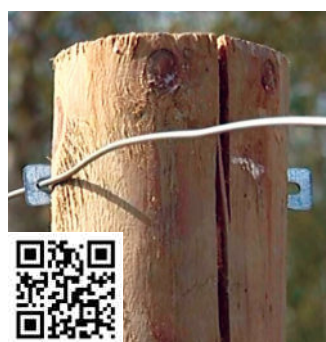
Crampillon installé et replié. Scanner pour visionner la vidéo.
