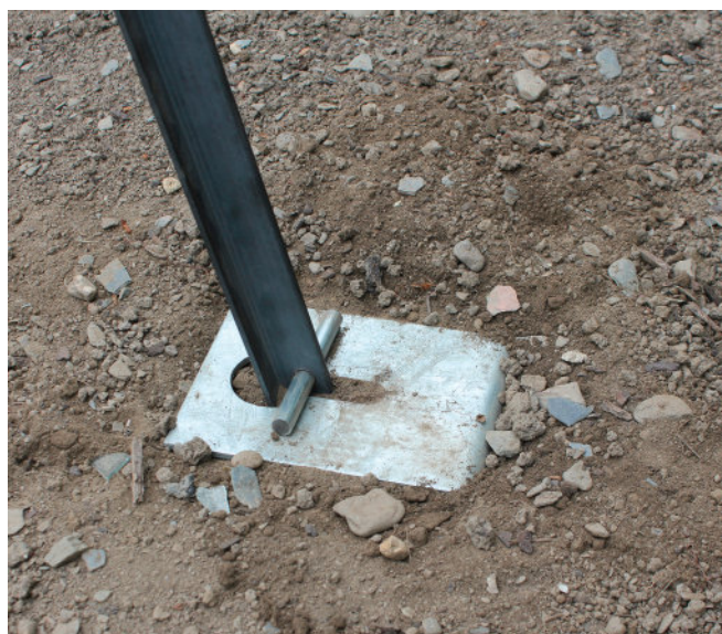
Plaque anti-enfoncement avec piquet "T".
