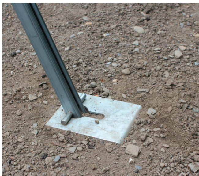
Plaque anti-enfoncement avec piquet L30.
