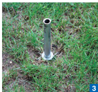
Despliegue de las varillas con el mandril placa abierta.
