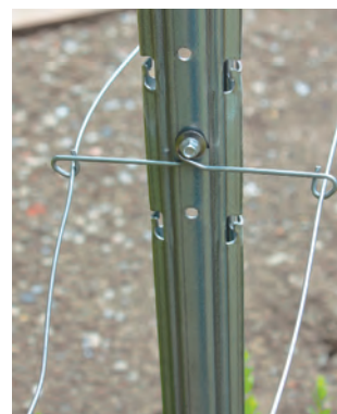
Cruceta flexible L150 mm sobre poste metálico.
