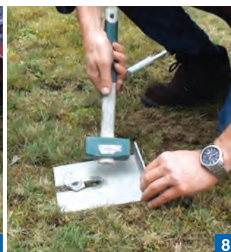
8 Retire la placa de colocación.
