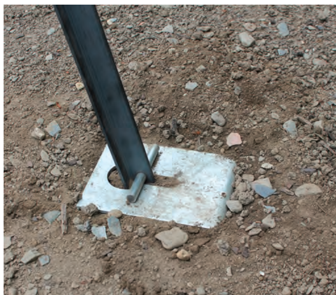
Placa anti-hundimiento con poste "T".
