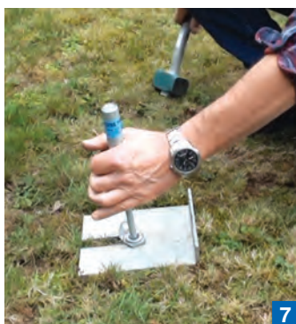
7 Desplegar los alambres con el mandril.
