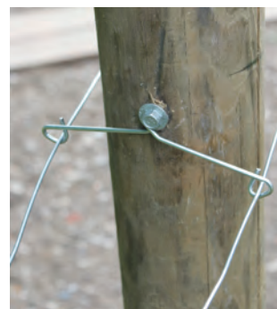
Cruceta flexible L150 mm sobre poste madera.
