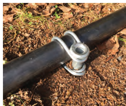
Tubo fijado con clip de alambre y anclaje.
