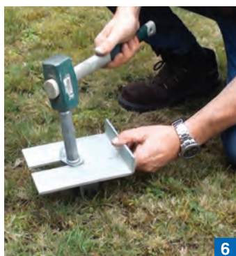
6 Colocar la placa entre el bracket y la cruz, seguir clavando.
