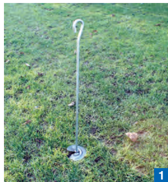
1 Monte la varilla y el disco y comenzar a atornillar el anclaje en el suelo.
