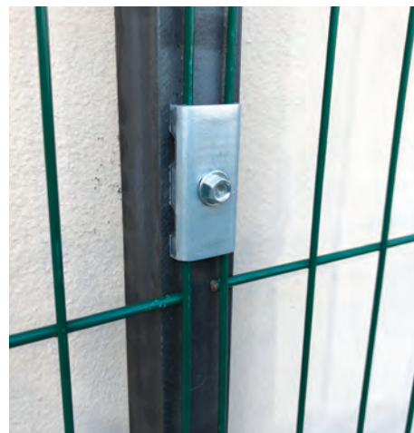
Malla rígida sostenida con pletinas tipo 1.
