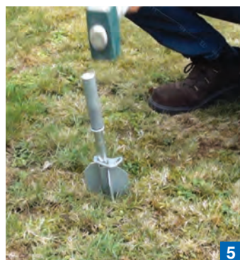
5 Clavar el anclaje con el util.
