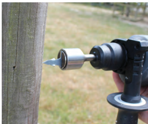
Colocación grapa arpón con clavadora.
