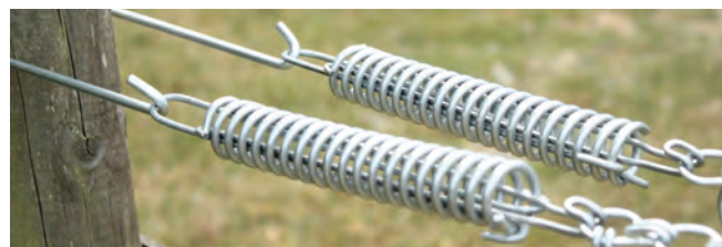
Tensor muelle colocado.
