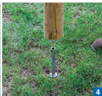
Colocación del poste madera sobre el anclaje.
