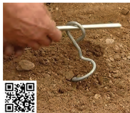
Colocación del anclaje tirabuzón. Escanear para visionar el video.
