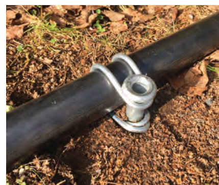
Tubo fijado con clip y anclaje.
