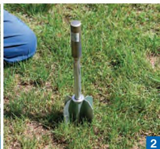
Colocación del anclaje con el util de clavado.
