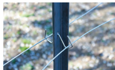
Cruceta simétrica colocada poste en T.
