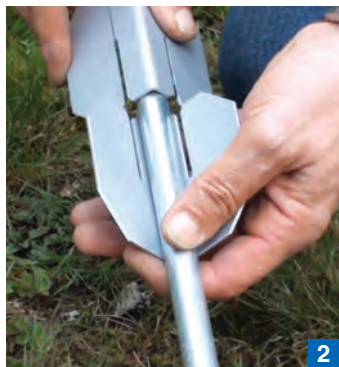
2 Aplique la 2ª parte de la cruz a lo contrario de la 1ª, deslice las ranuras entre sí contra el cuerpo del amarre.
