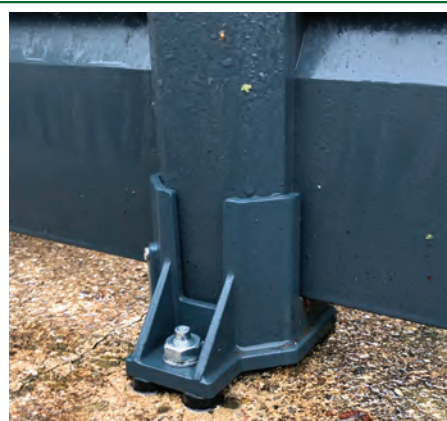
Fijación de una pletina sobre hormigón.
