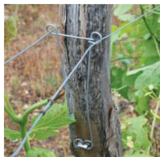
Separador fechado em poste de madeira.
