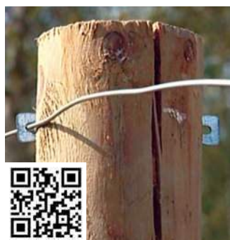
Grampo instalado e dobrado. Digitalizar para ver o vídeo.
