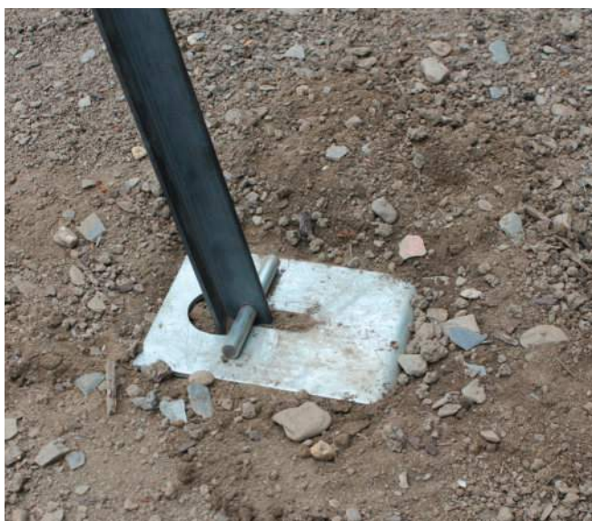
Placa antiafundamento com poste em "T".
