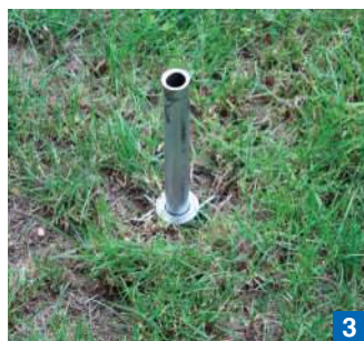
Implantação das hastes utilizando o mandril e a placa fendida.
