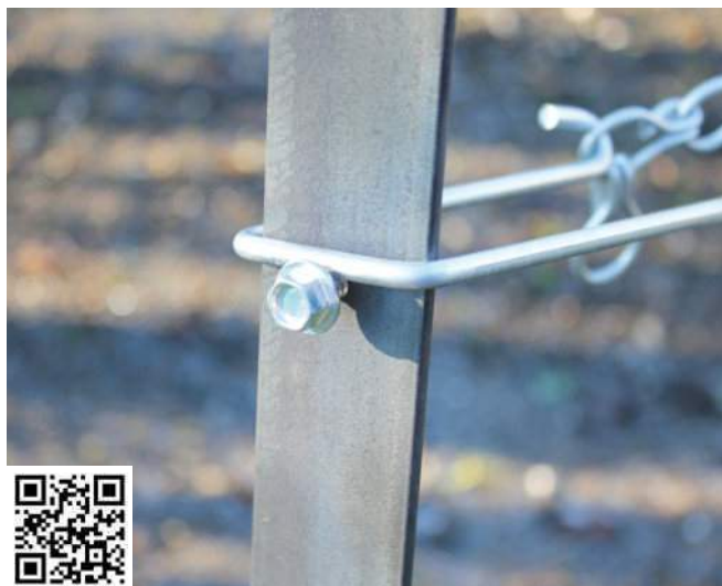
Forquilha quadrada galvanizada com parafuso autoperfurante sobre poste metálico. Digitalizar para ver o vídeo.
