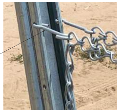
Ganchos no poste com perfurações laterais.
