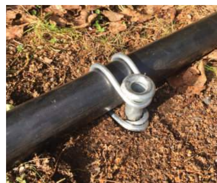
Tubo fixado utilizando o gancho de arame e a amarra.
