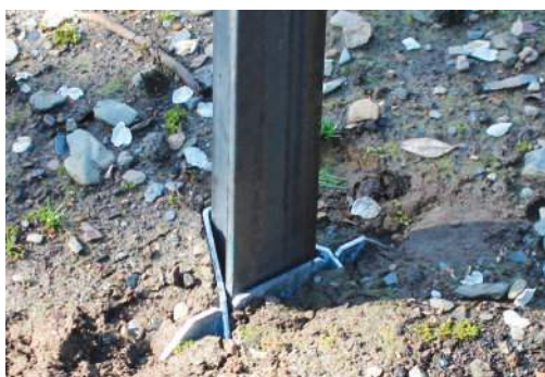
Poste em "T" com cruz de reforço.
