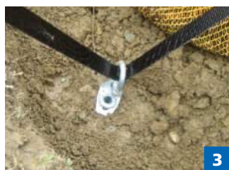
Colocação da cinta.
