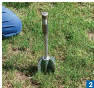
Cravação da amarra utilizando a ferramenta de cravação.
