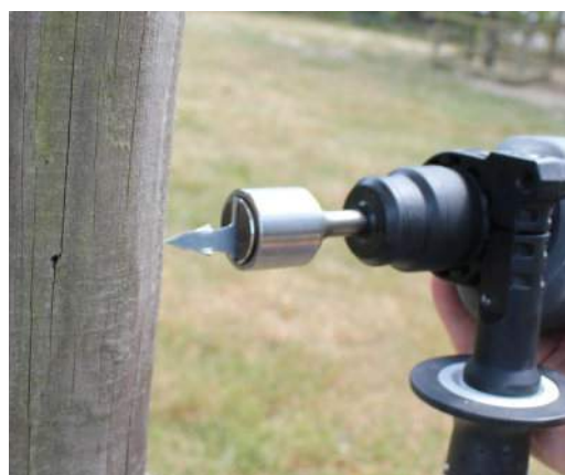
Instalação da ponta do extensor com a ferramenta de pregar
