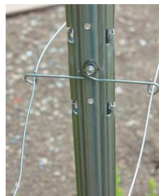
Extensor de arame de mola L150 mm em poste metálico.
