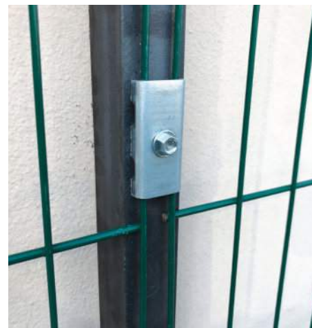
Aramação rígida fixada com placas tipo 1.
