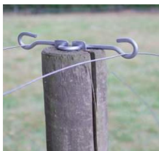
Guia de arame móvel em poste de madeira.
