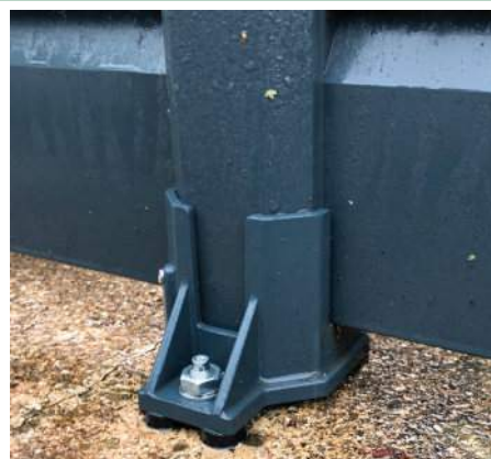
Fixação de placa de paliçada em betão.
