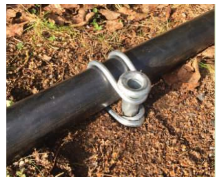
Tubo fixado utilizando o gancho de arame e a amarra.
